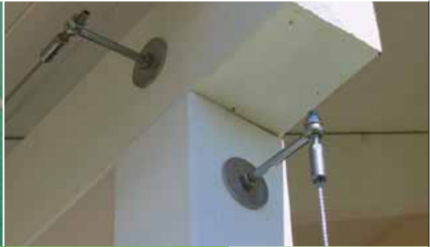
Augenschrauben als Abstandhalter mit Wandabstand 9 cm für geringe Belastung
