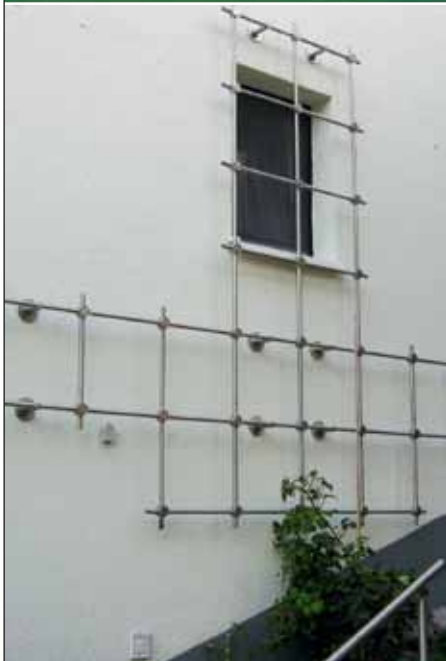
Abstandhalter mit Wandabstand 15 cm für Rankstäbe aus Edelstahlrohr
