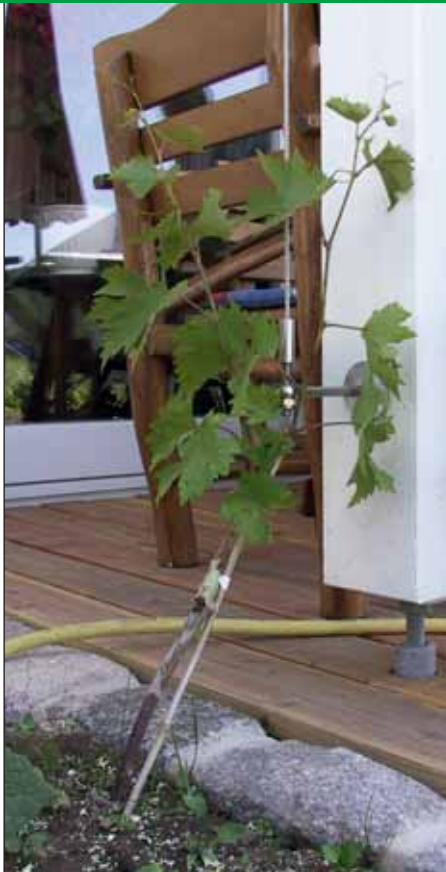
Augenschrauben als Abstandhalter mit Wandabstand 9 cm für geringe Belastung
